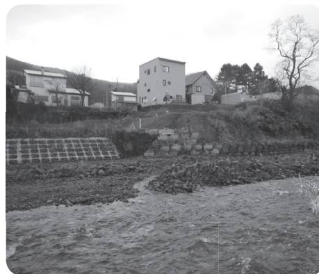
▲護岸工事予定箇所
