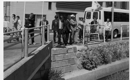
▲日本橋長寿命化修繕工事(日司町)
