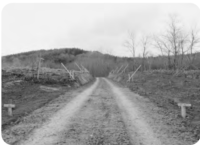
▲基幹作業道（婦美六地区）
