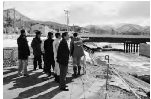
▲美国川河川改修工事
