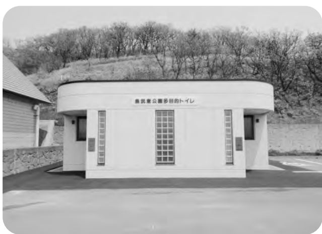
▲島武意公園多目的トイレ
