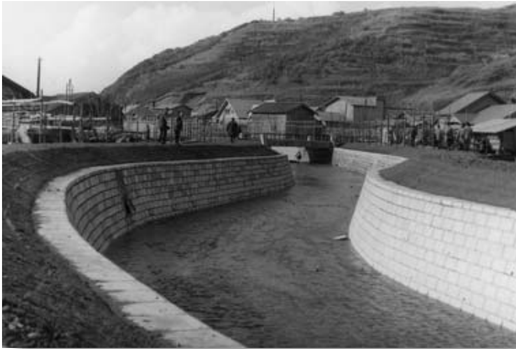
昭和44年10月、入舸川復旧工事完成。昭和42年2月の融雪期に豪雨を伴って大災害を受けた入舸川でしたが、天然で人為工作物の加わらない原始河川から高さ2mの積ブロック護岸に60cmの堤防が完成しました。 また併せて月見橋と中央橋が永久橋に架け替えられたほか、木造人道橋2か所が新設されました。
