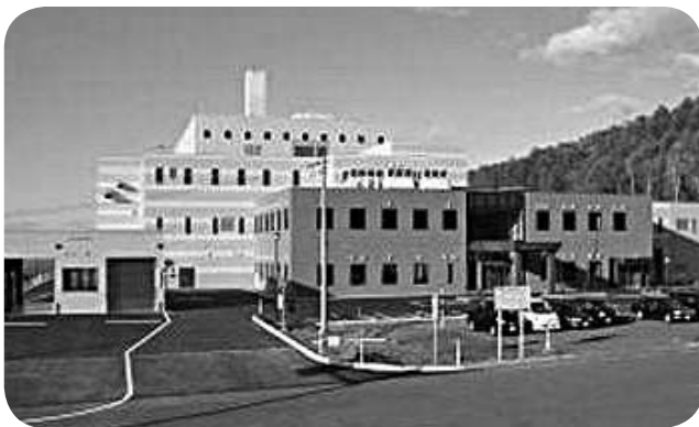
北しりべし広域クリーンセンター（小樽市桃内） （ごみ焼却施設 / リサイクルプラザ）
