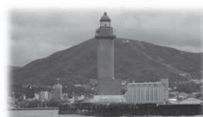
小樽港北副防波堤灯台（小樽市）
