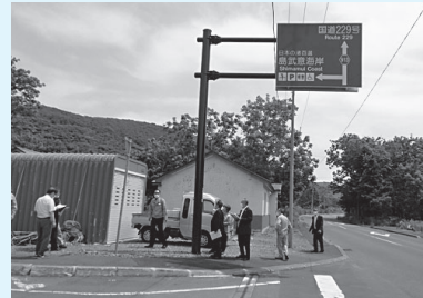
▲島武意誘導案内板設置等工事
