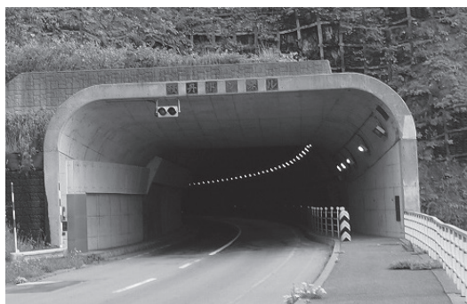
▲積丹トンネル（沼前側）
