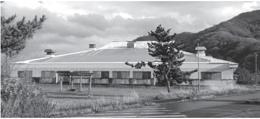
▲老朽化が進む積丹町水産種苗生産センター
