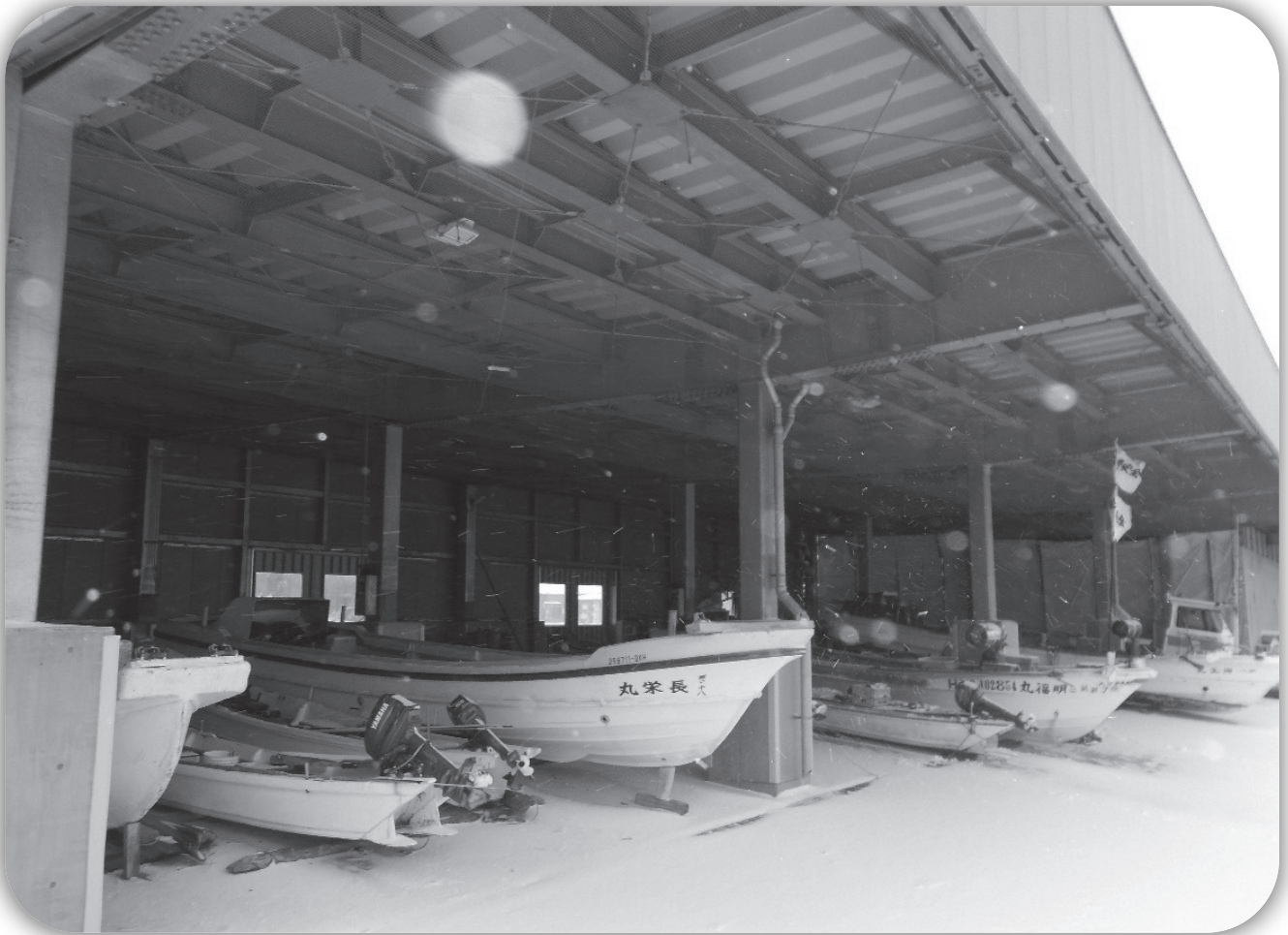
【整備が進む屋根付船揚場(美国漁港)】
