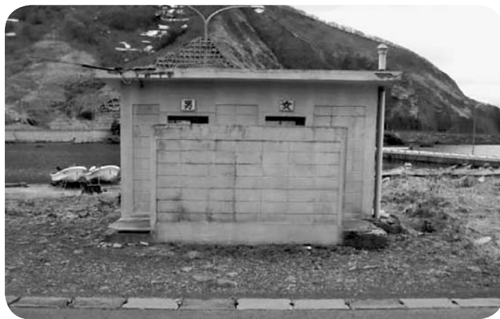
入舸漁港公衆トイレ
