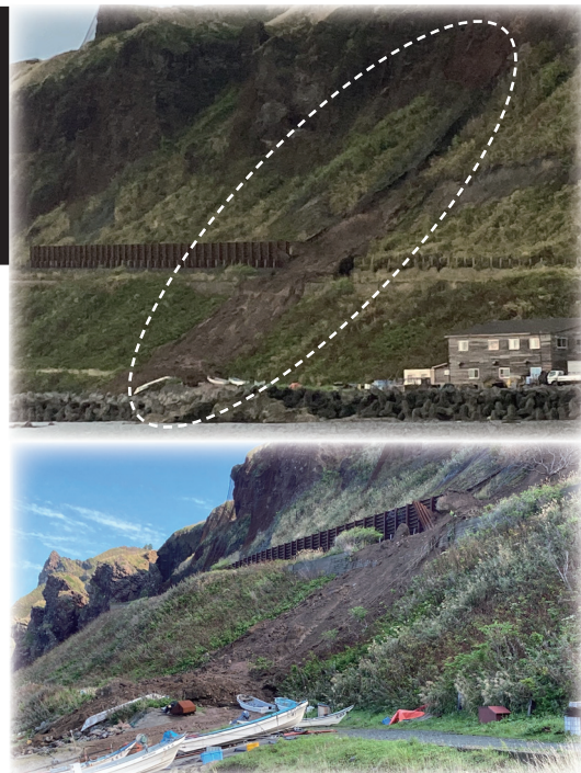
※令和5年9月大雨による土砂崩れ（神岬町）
