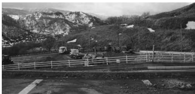
▲島武意通り線道路改良工事
