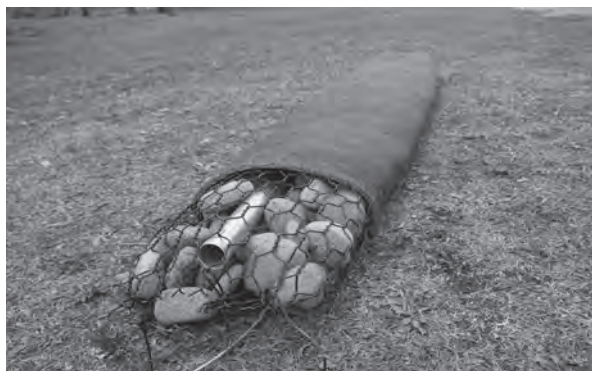
▲余別新川に設置したジャカゴ
