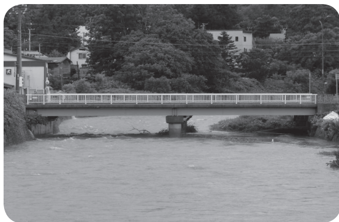
▲解体前の旧美国橋
