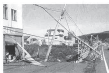
倒れた電柱 (橋本町)
