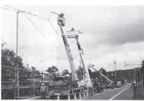
電線の復旧作業 (橋本町)
