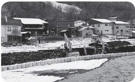
▲寺町側の護岸工事
