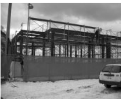
完成が待たれる余別漁港冷凍冷蔵保管施設
