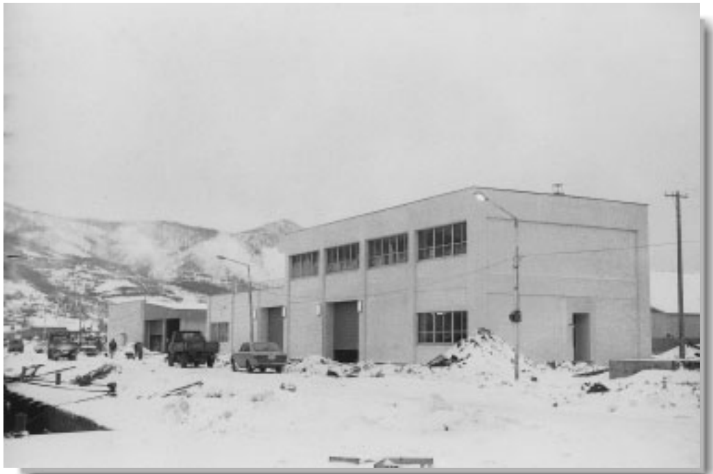
昭和45年12月、美国漁港荷捌所及び冷蔵庫完成。美国町漁協と積丹漁協の共同施設として建設されました。冷蔵庫の凍結能力は日産5トン、冷蔵能力は200トンの近代施設として魚価の安定、効率的な処理能力の向上が図られました。
