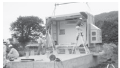
▲ IP-BOX施設（テレビ再送信施設）設置工事（美国町）
