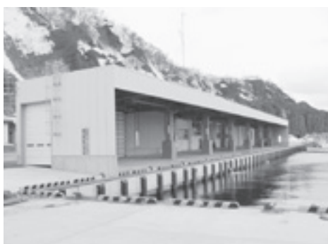
▲町内初の余別漁港屋根付岸壁
