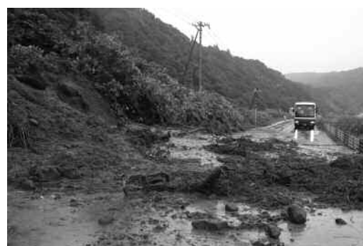
▲土砂崩れにより寸断された国道229号(西河町)
