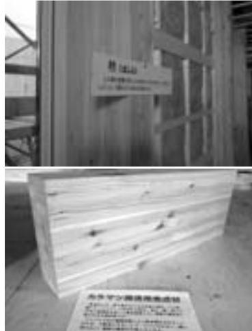
梁（写真上）や柱（写真中）など、主要な構造部に使われている積丹産カラマツ集成材（写真下）。
