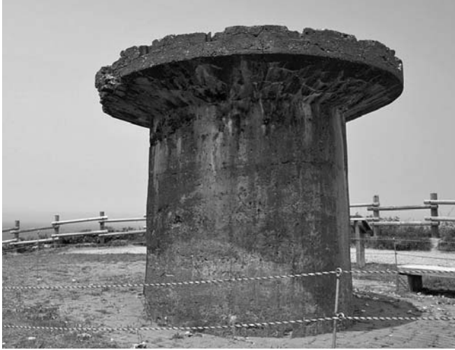
▲ 昭和17年に旧日本軍が建設した電磁台
