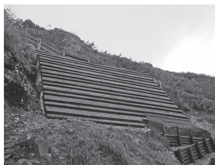
▲ 自然公園地域内の景観にも配慮した木製土留工
