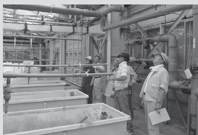
▲ 休止中の水産種苗センター内部
