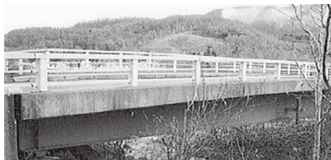
▲新美国橋（昭和 62 年建設）
