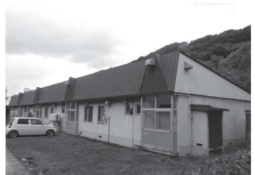
▲日司団地(1棟4戸：S57年建設)
