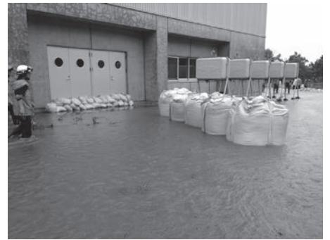
▲余別小学校裏へ土のうを設置
